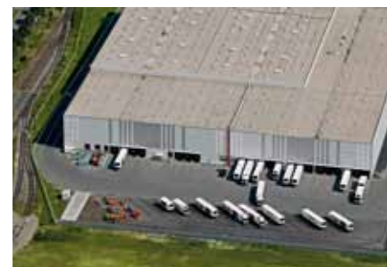
Zentrallager sind ein wichtiger Teil einer effizienten Logistikprozesskette und unterstützen zudem die Warenverfügbarkeit in den Märkten. Im Lager Hamm werden vor allem Tiefkühlprodukte zwischengelagert.
