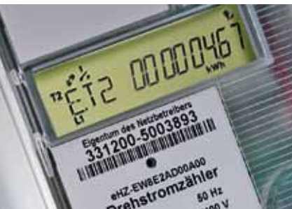
Mit dem METRO GROUP Energy Management System (MEMS) kann der Energieverbrauch eines Standortes kontinuierlich gemessen und detailliert ausgewertet werden. In Europa waren 2010 bereits 726 Märkte mit diesem System ausgestattet.
